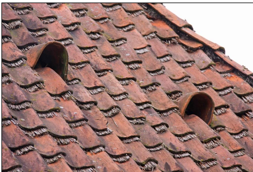
Een zojuist opgeleverd historisch pannendak voorzien van strodokken, met twee licht- of luchtpannen.
